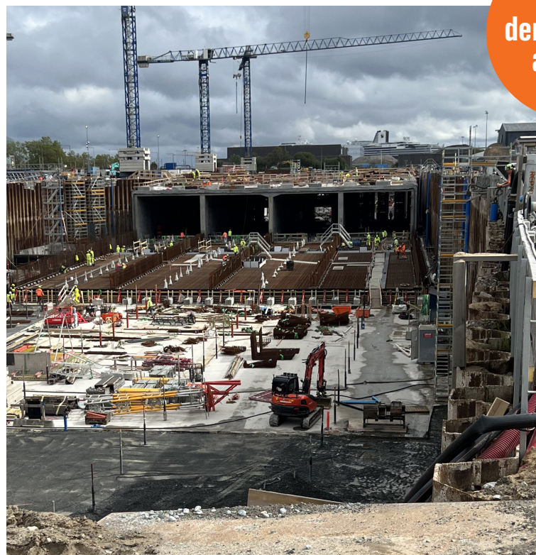
Tunnelbyggeriet. Kig ind i rørene.
