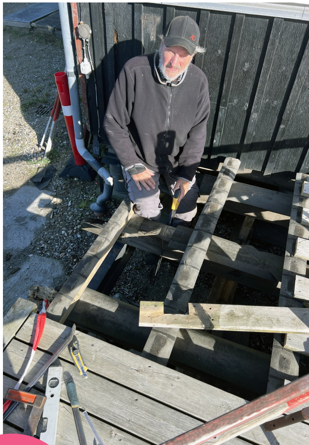
Renovering af terrassen. Lars skærer råddenskab på terrassen væk med håndsav.
