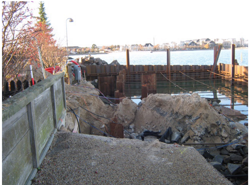
Spunsen til optagekajen for enden af vores brandvej, er banket.
