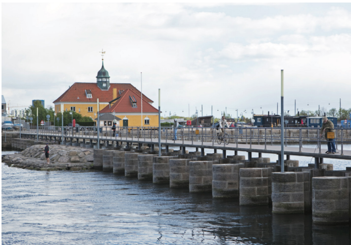
Slusen set fra Sjællandssiden med slusehavnen og sluseanlæggets bygninger bagved.
